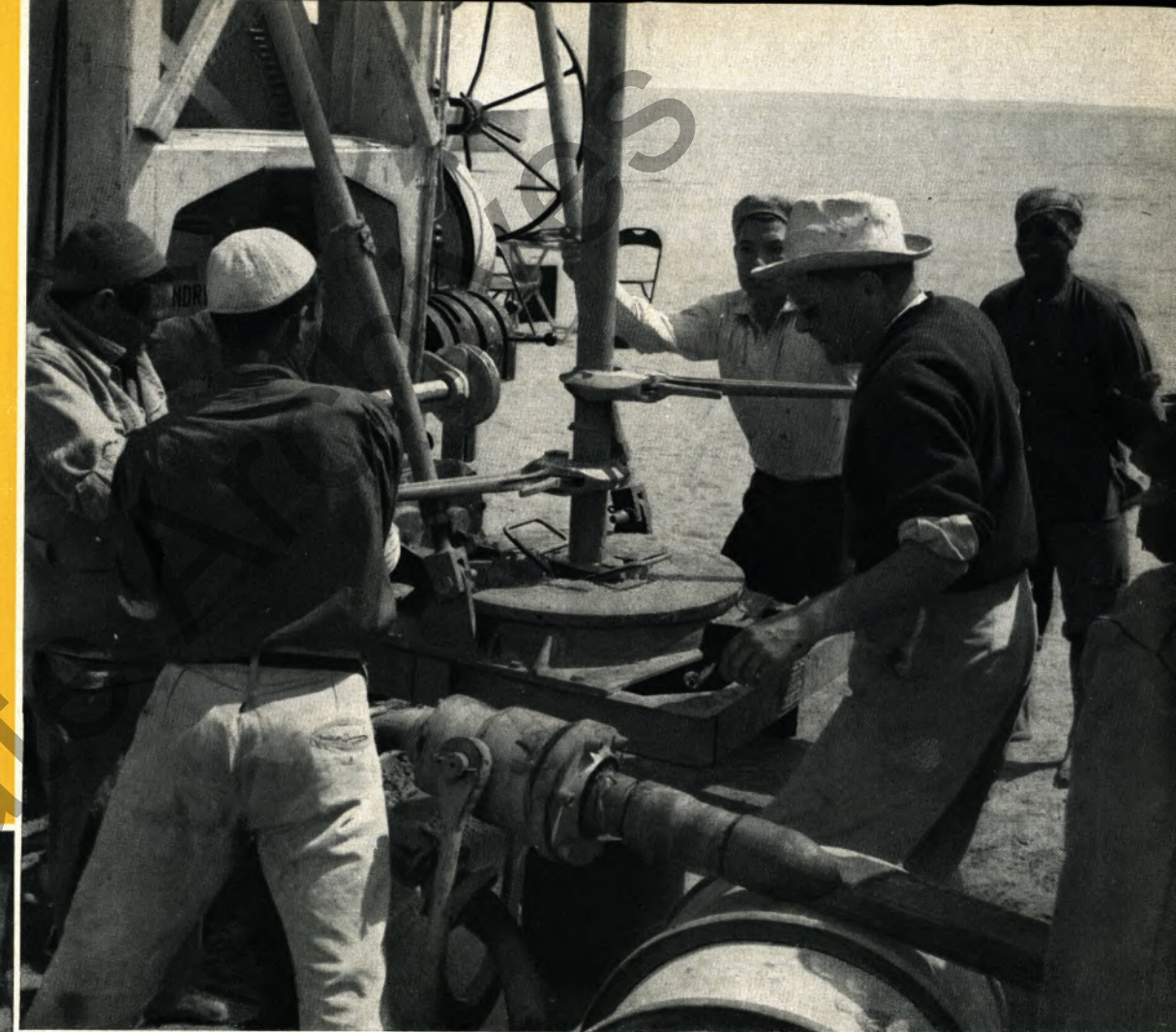
Der Rollenmeißel senkt sich durch den Drehtisch in das Bohrloch. Ein eindrucksvolles Bild aus dem jüngsten Ölland der Welt, der kanadischen Provinz Alberta.
