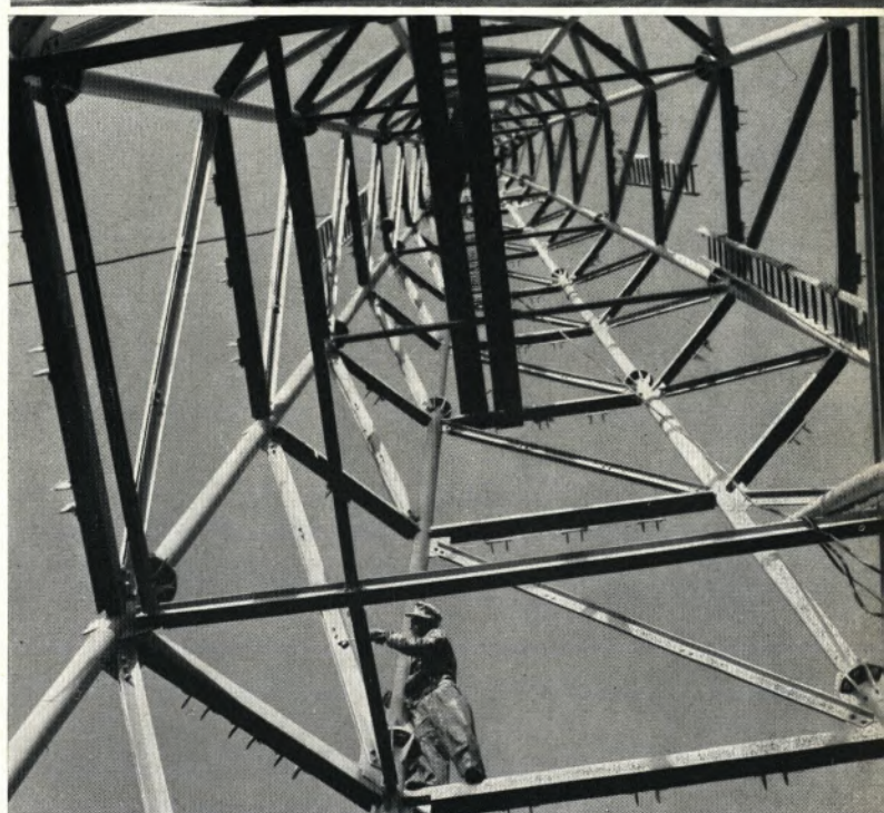
Mülheims Wahrzeichen, der Petriturm, entsteht neu. Monteure der Rohr- und Stahlbau GmbH, Dinslaken, haben den 37 Meter hohen Turmhelm in das alte Gemäuer eingesetzt. In der Stahlkonstruktion sind Rohre und Profileisen verarbeitet. Phoenix-Rheinrohr lieferte die verwendeten 250 m Rohre im Gewicht von 7 t aus Stahl St 35.29. Wir werfen einen Blick auf die Kirche und schauen in das Stahlfiligran des Turmhelmes.
