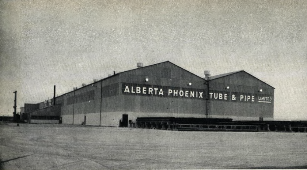
Das ist die Stirnseite der Doppelhalle unseres modernen Werkes Alberta-Phoenix in Edmonton. Durch die großen durchlaufenden Plastikbänder dringt genügend Tageslicht in das Innere ein
