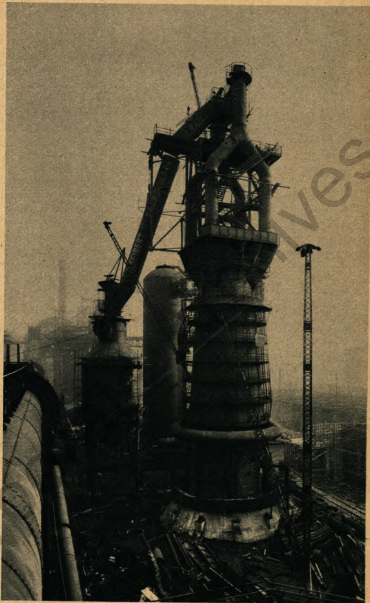
Der Hochofen 7, wie er heute in der Westfaluenhütte in Betrieb ist, im Bau. Man sieht deutlich den Unter- und Oberofen, also Schacht, Rast und Gestell. Das Gerüst ist noch nicht montiert.
