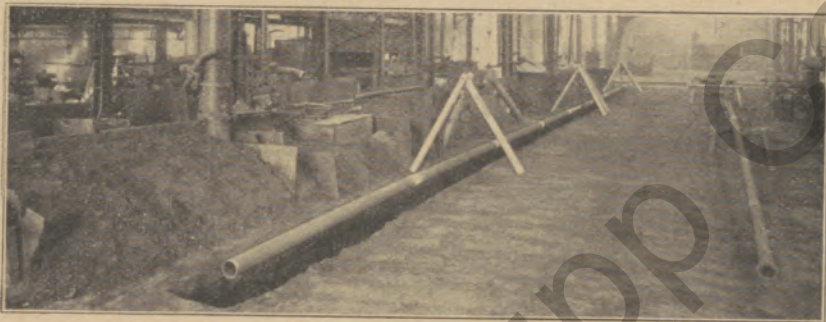
Absenkung des Rohrstranges.
