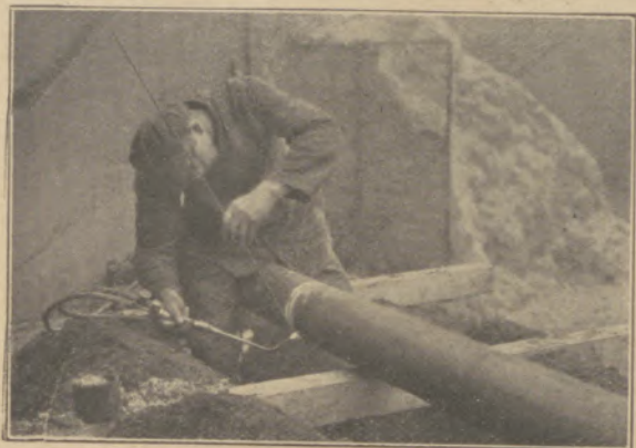
Gußrohrschweißung über dem Rohrgraben.
