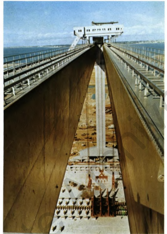
Thyssen-Bleche für die Montagebrücke einer spanischen Werft, die Thyssen-Bleche im Schiffsbau einsetzt.
