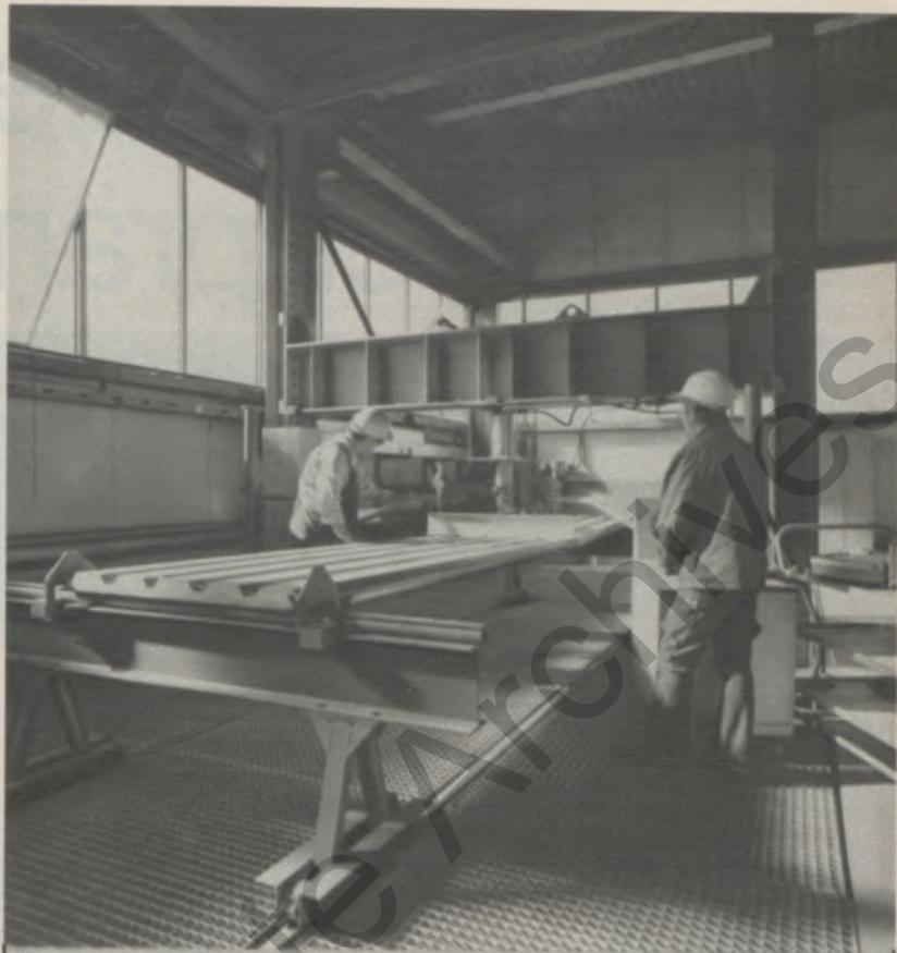
Nun beginnen die Versuche, die das neue Bauelement produktionsreif machen sollen: beispielsweise Belastungsversuche, um die Tragfähigkeit zu ermitteln
