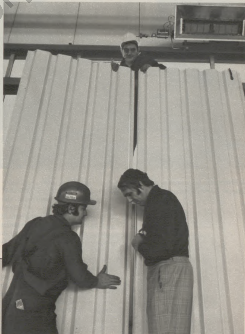
Hier werden die Ausbildung des Stoßes und die einfachste und sicherste Methode der Montage von Ernst Marschinski, Günter Geisweid und Dipl.-Ing. Stemmann, dem Leiter des Entwicklungszentrums, überprüft
