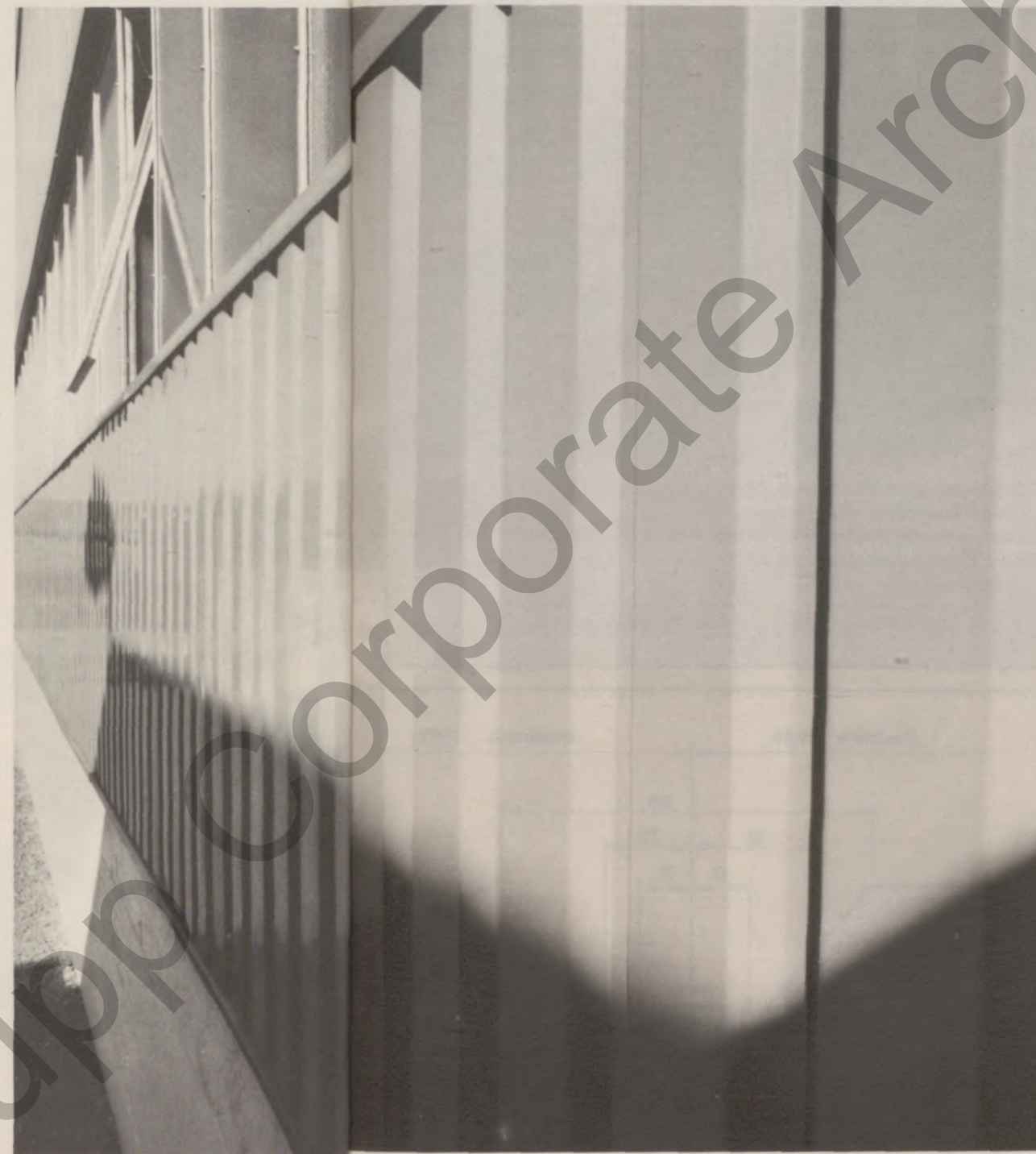
Die Wandverkleidung der Versuchswerkstatt besteht aus HOESCH-isowand T 35, einer Variante der bekannten HOESCH-isowand mit kräftig gegliederter Oberfläche
