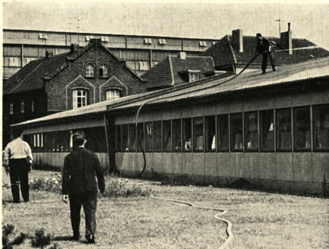
An heißen Tagen spritzten Männer der Thyssenwehr Wasser auf die Dächer unserer Fertighäuser, um die Hitze in den Büros zu mildern
