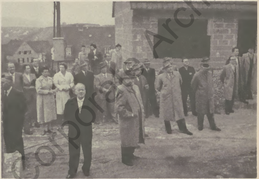
Siedler und Gäste an der Baustelle . . .
