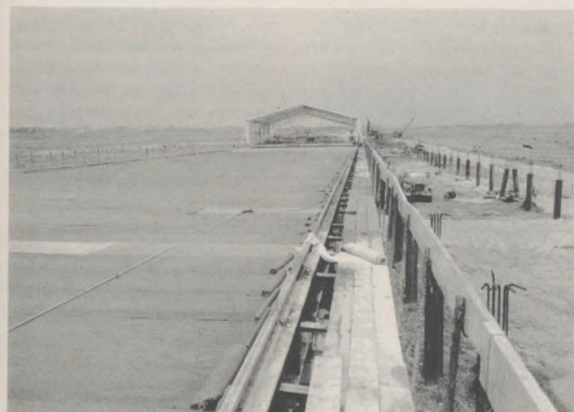
▲ Aus Stahlbeton stellte der größte »Straßenfertiger« der Bundesrepublik die Fahrbahn her
