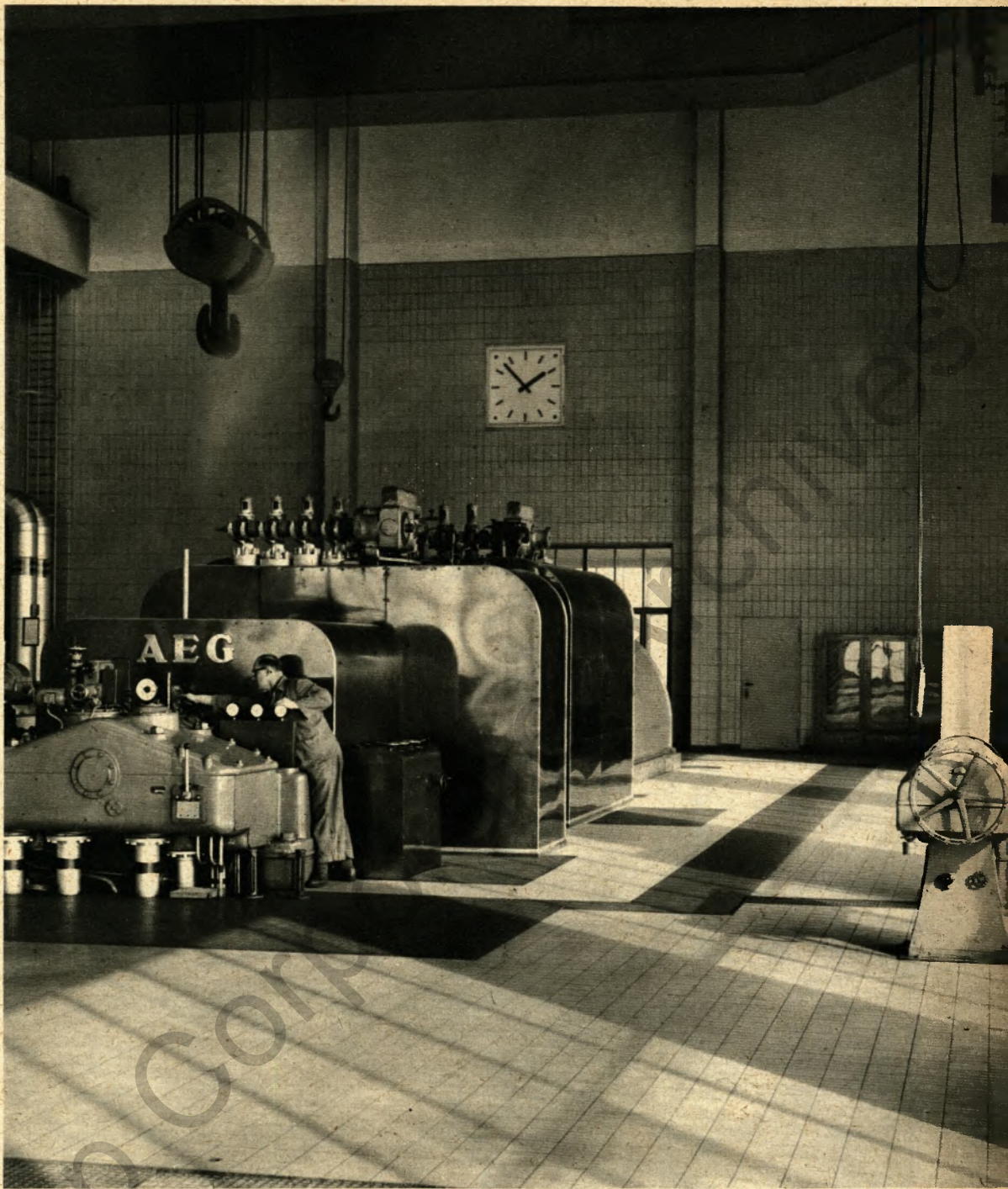
▲ Blick auf die Turbinen im Kraftwerk Emscher, das die Schachtanlagen der Altenessener Bergwerks-AG mit Strom, Dampf und Preßluft versorgt. Maschinist Gerhard Rother an der Vorschaltturbine
