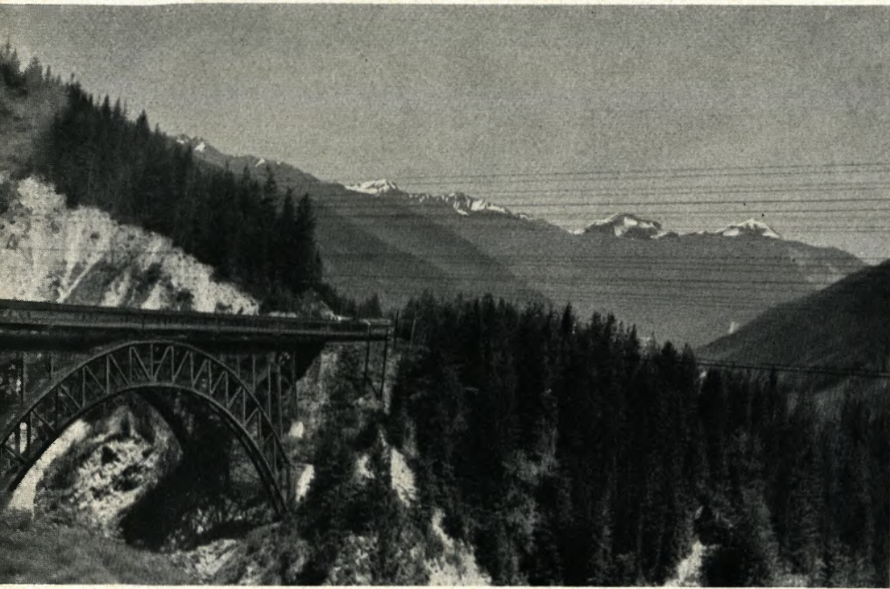
Über tiefe Schluchten und durch dichte Wälder bahnt sich die Bahn hier ihren Weg durch die Rocky Mountains nach Banff. Sie bildet vorerst den einzigen Verkehrsweg zwischen den Städten Westkanadas
