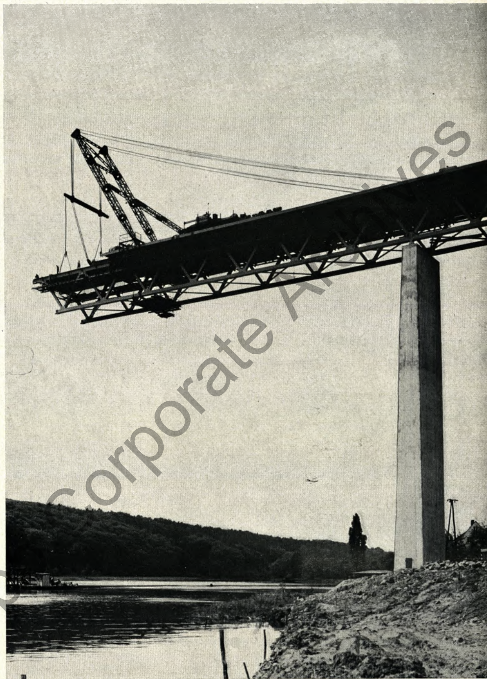
Im freien Vorbau erstet die Brücke südlich von Kassel. 50 m über dem Wasserspiegel mußten die Monteure ihre gefährliche Arbeit ausführen. Die größte Länge des vorkragenden Brückenteils betrug 75 m
