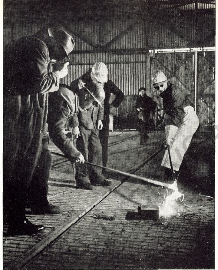
Im Stahlwerk werden von jeder Charge Proben genommen; unser Bild zeigt eine solche Probenahme im neuen SM-Stahlwerk
