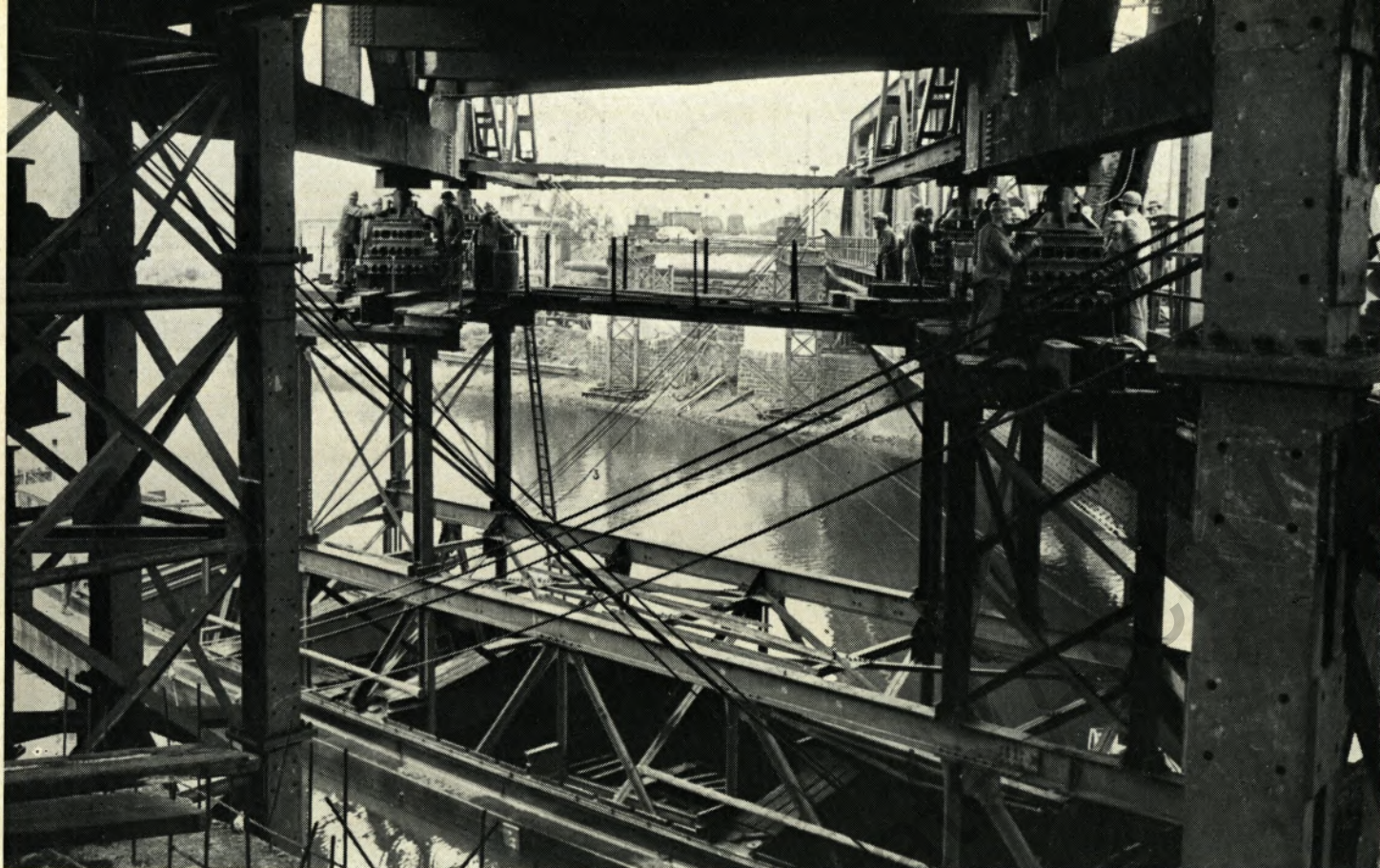
Das Schiff ist unter die Brückenkonstruktion gesetzt worden. Das Brückenende wird auf die Aufbauten und Pressen aufgelegt.
