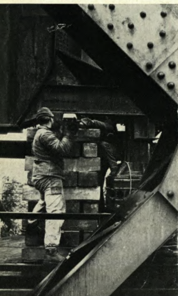
Vor dem Einschwimmen werden zusätzliche Lagerböcke eingebaut, die die Konstruktion tragen.
