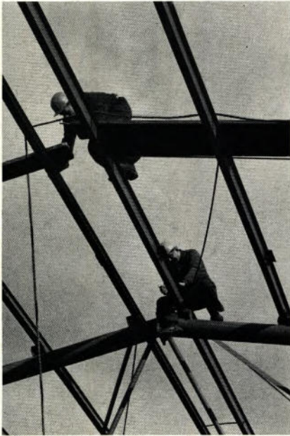
Titelseite: In schwindelnder Höhe werden Pfetten und Rohrbinder verschraubt. Erfahrung und Sachkenntnis gehören zur Montage der Rohrkonstruktion. Auf unserem Bild montieren Bernhard Jäschke und Werner Duffe das Dach der Güterumschlaghalle des Bahnhofs Köln-Gereon
