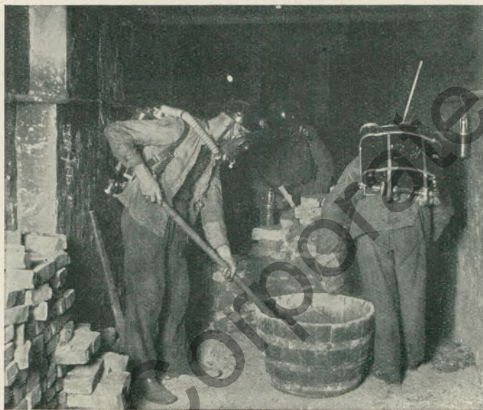
Ziehen einer Brandmauer.
