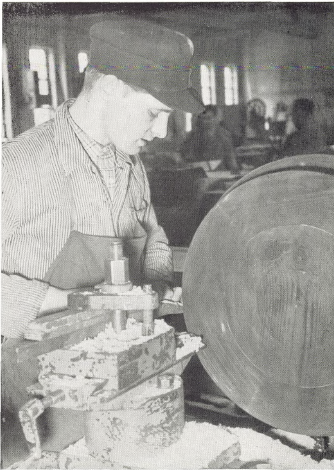
Hier kommt es auf Bruchteile von Millimetern an. Modelldrechsler Ewald Spickermann ist an der Drechselbank daher auch mit höchster Konzentration bei der Sache
