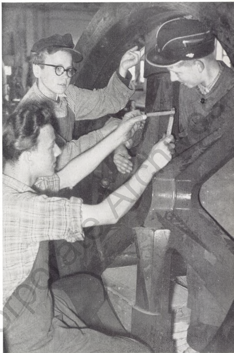
Die Lehrlinge Werner Michel (mit Brille) und Herbert Denninghoff, beide im April 1956 eingetreten, sind für den erwähnten Beruf begeistert. Am Modell eines Trommelzahnades für einen Kran bei der Nachprüfung der Maße mit Modellschreiner Günther Hojka, der ihnen die notwendigen Griffe zeigt
