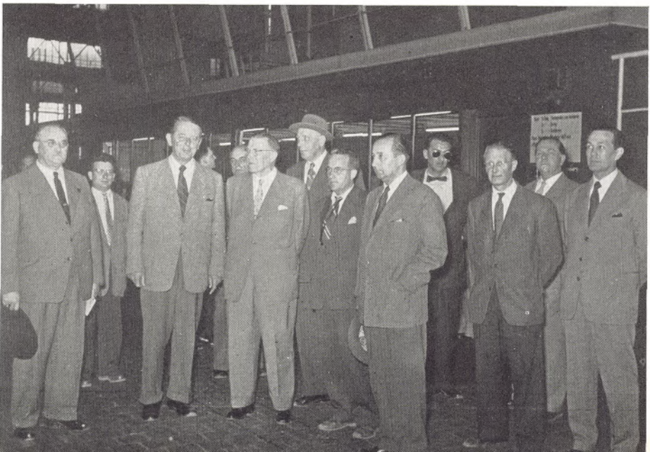
Führende Herren der französischen Hüttenwerke besichtigten Betriebe unserer Hütte, insbesondere die Ofenanlagen — auf unserem Bild in der Breitbandstraße mit den Direktoren Heischkeil und Dr. Schmitz, die bei dem Rundgang die Führung übernommen hatten
