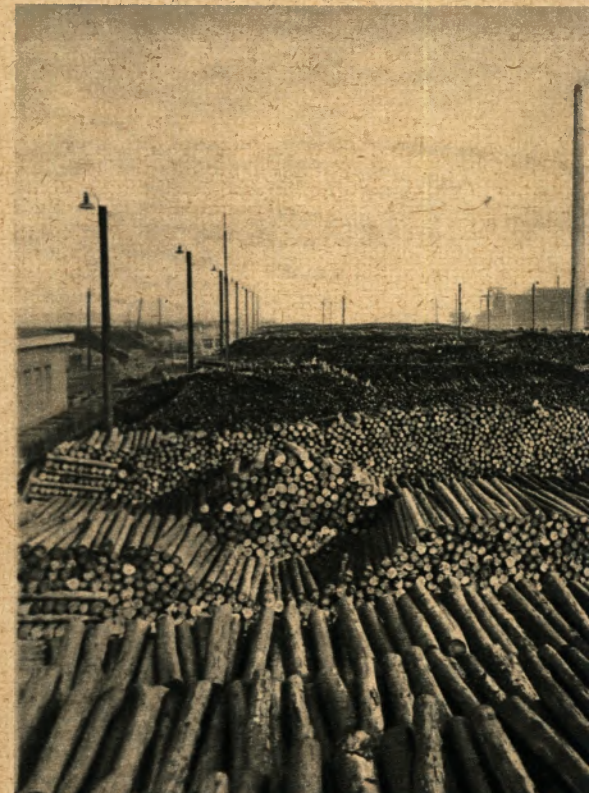
Vor der Kokerei Emil liegt das gewaltige Grubenholzlager
