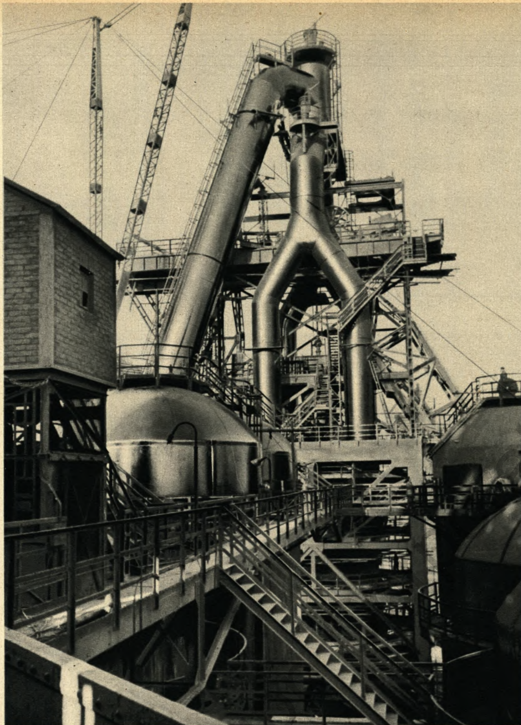
Gichtgasabzugsrohre an dem Anfang 1954 fertiggestellten Großhochofen VI
