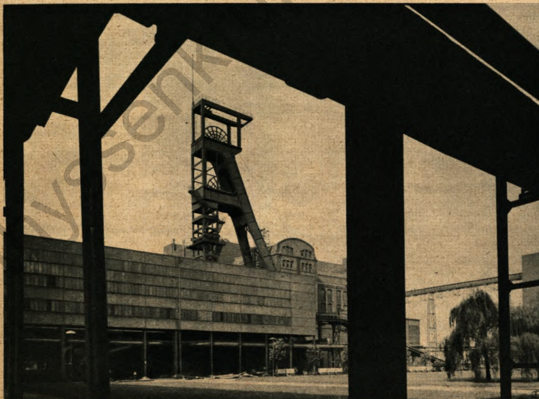
Schacht Fritz II mit Kohlenseparation und Wäsche auf der Schachthanlage Fritz-Heinrich in Altenessen
