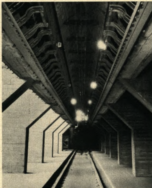
Neue Bunkeranlage des Hochofens VI mit Fahrgleis und modernen Bunkerverschlüssen
