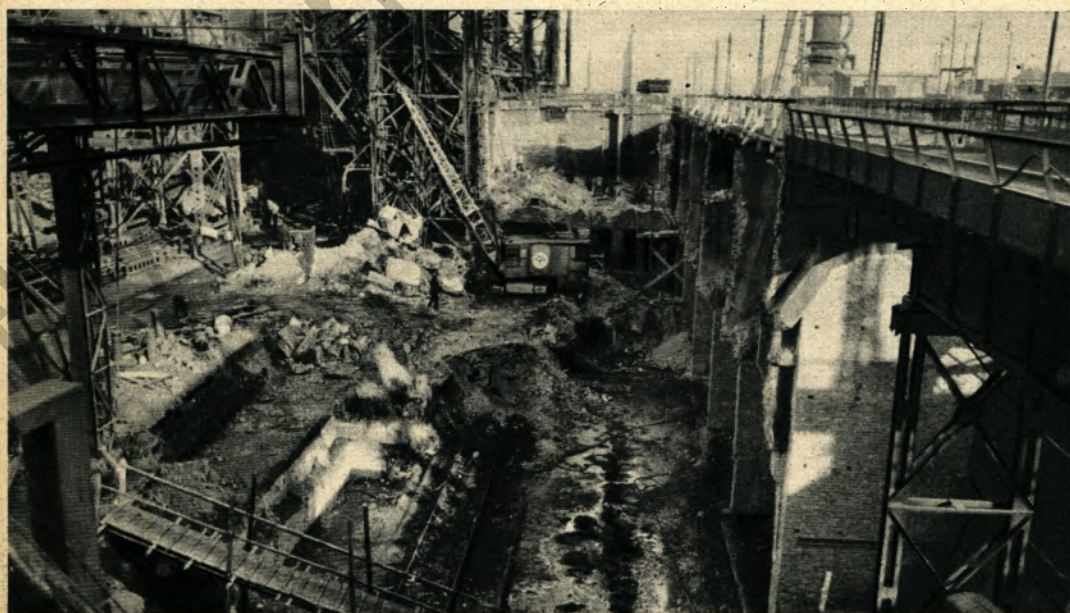
Die alten Bunkeranlagen werden abgebrochen und mit Raupenbagger verladen
