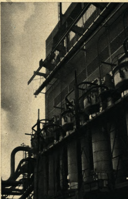
Einer der großen Kompressoren in der Sauerstoffanlage
