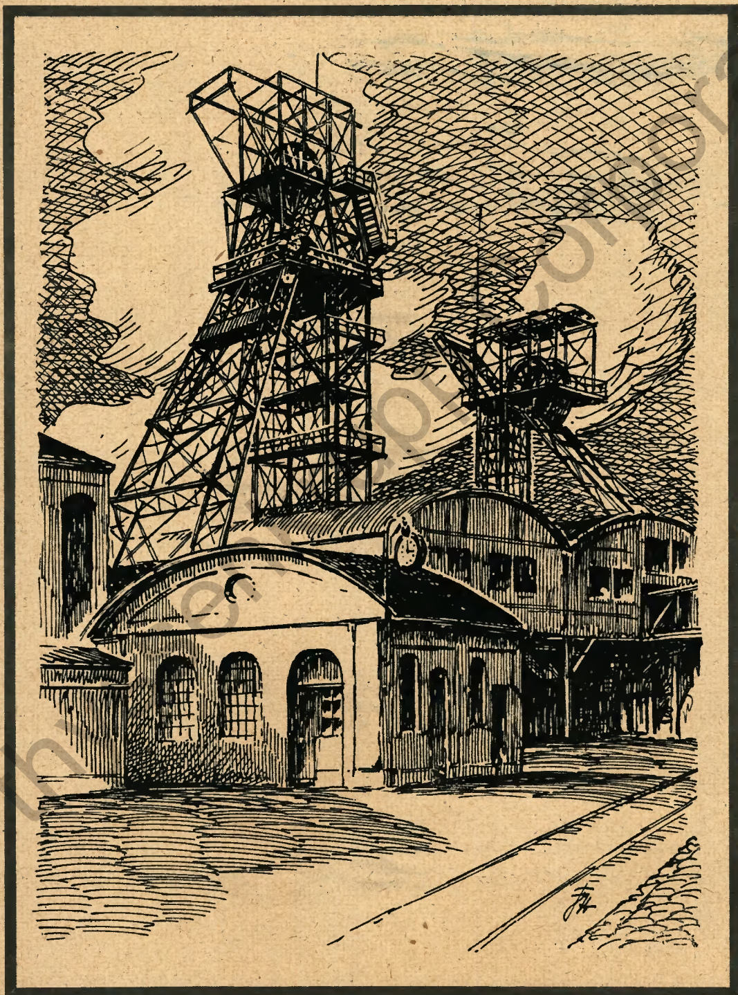
Schacht Emscher I und II mit dem ersten eisernen Seilscheibengerüst des Ruhrgebiets
