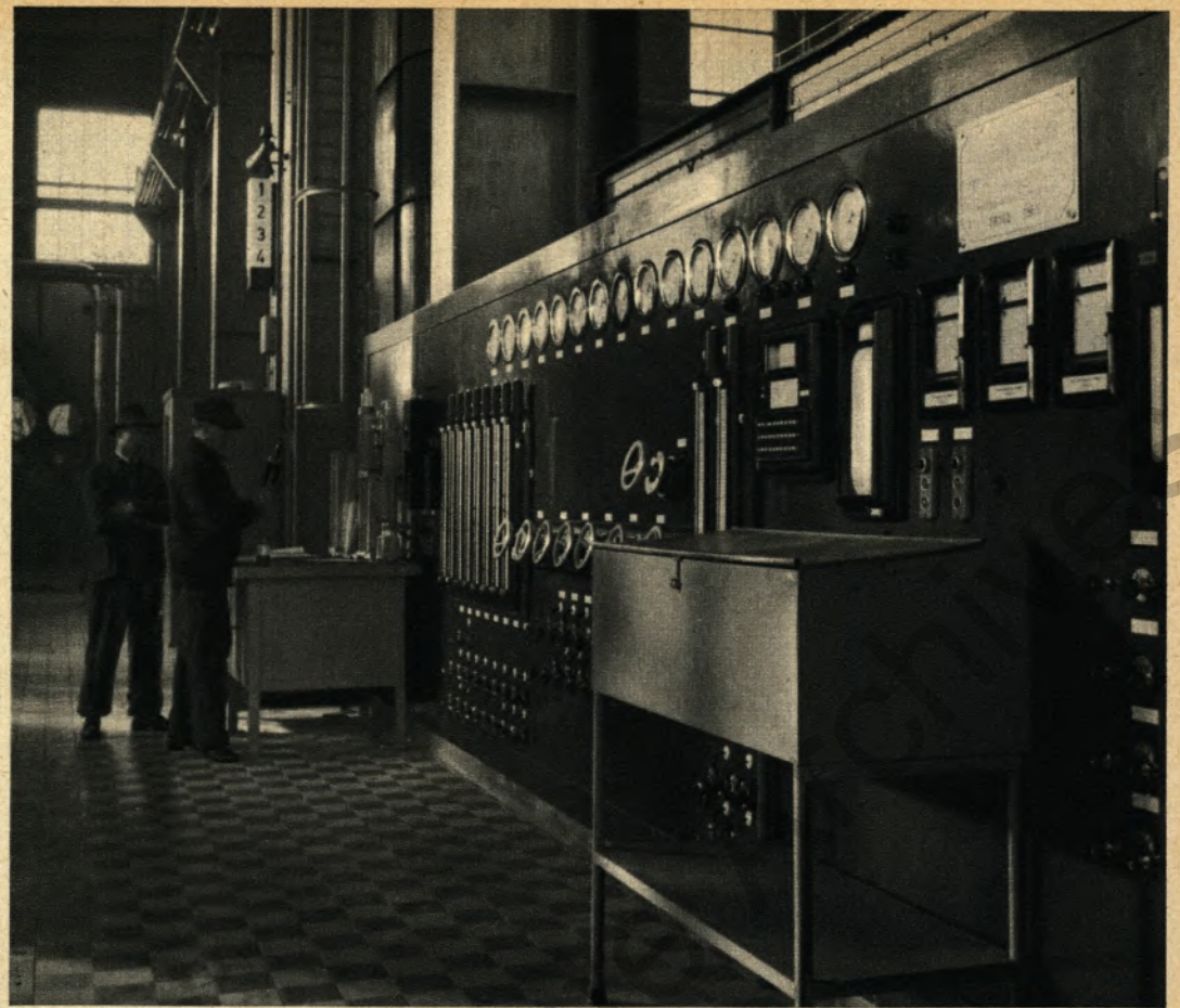
Die Sauerstoffanlage des Werkes ist eine der größten in Europa. Täglich werden 1,2 Million Kubikmeter Luft zu 250 000 Kubikmeter Sauerstoff verflüssigt und destilliert
