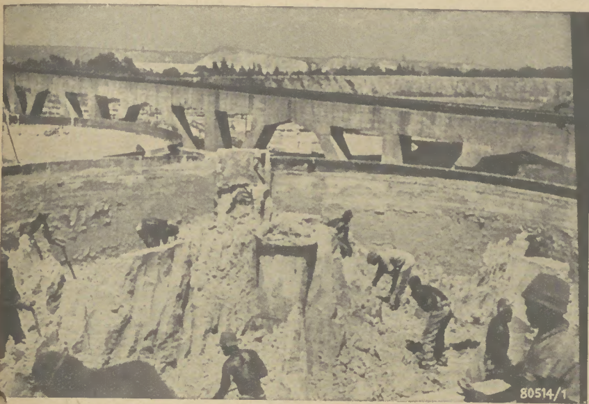
Durch schwarze Arbeitskräfte wird der mittels Zyankali entgoldete Gesteinsbrei aus den Tanks ausgeschaukelt und auf die Halden verfrachtet
