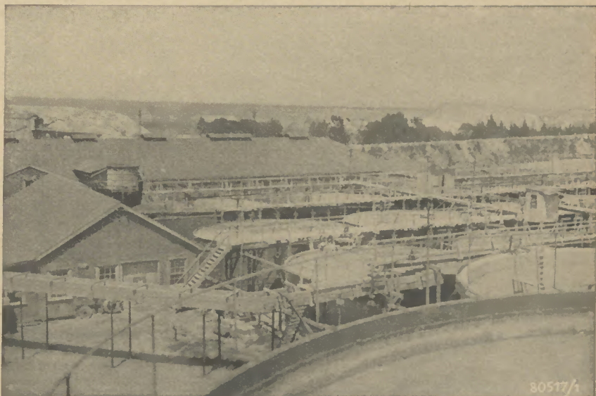
In gewaltigen Tankanlagen wird dem Gesteinschlamm durch Zyankalizusatz das Gold entzogen
