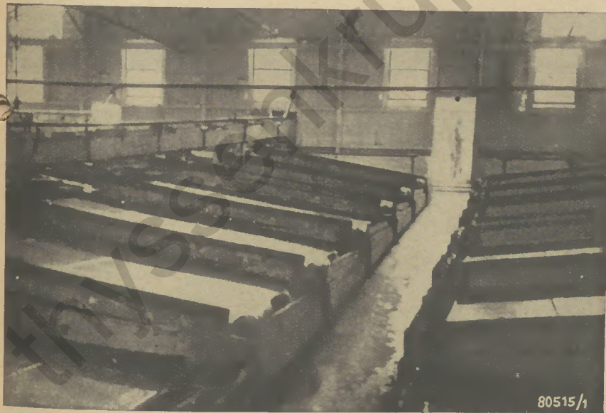
Hier läuft der mit Wasser stark verdünnte, Gold enthaltende Brei über Korbdecken, an denen sich die spezifisch schwersten Goldpartikelchen ansetzen. Nach mehrstündiger Prozedur werden die Korbdecken entfernt und das Gold von ihnen genommen
