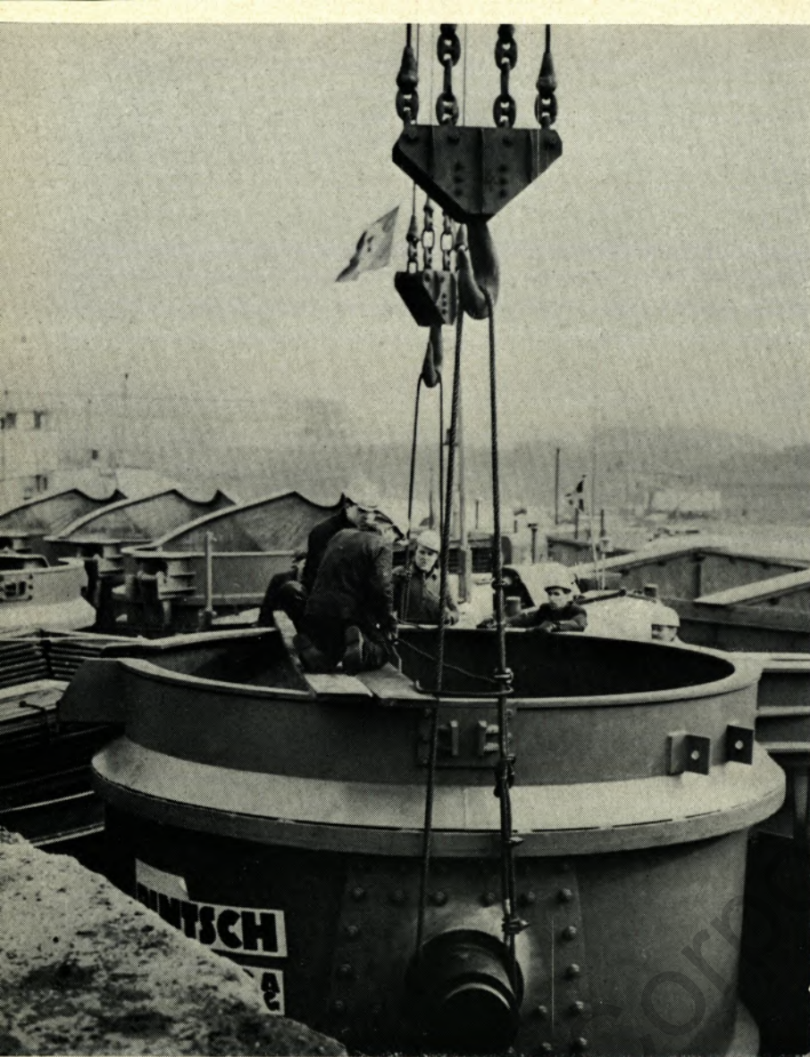
Handwerker der Mechanischen Werkstatt des Hafens sichern die 31 mm starken Drahtseile an einer Pfanne.
