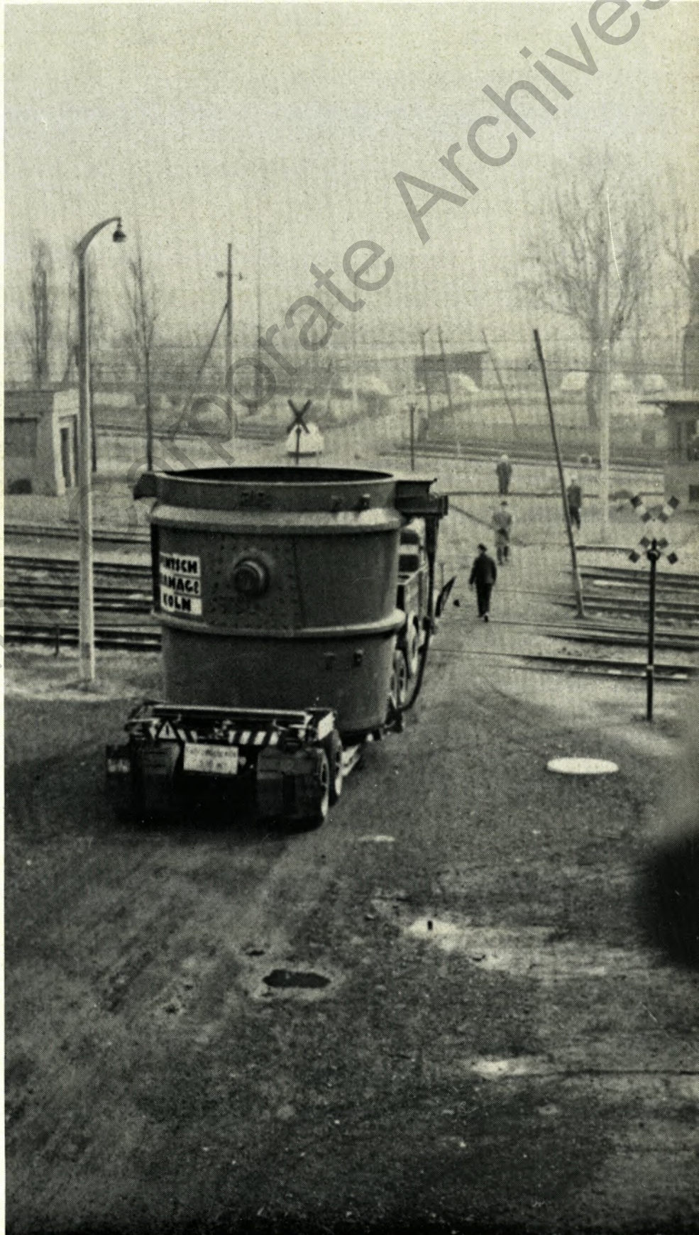
Eine Panne auf dem Weg zum Tor 12. Die Oberleitung der Werksbahn mußte beson- ders erhöht werden, damit das Fahrzeug profilfrei hindurchfahren konnte.
