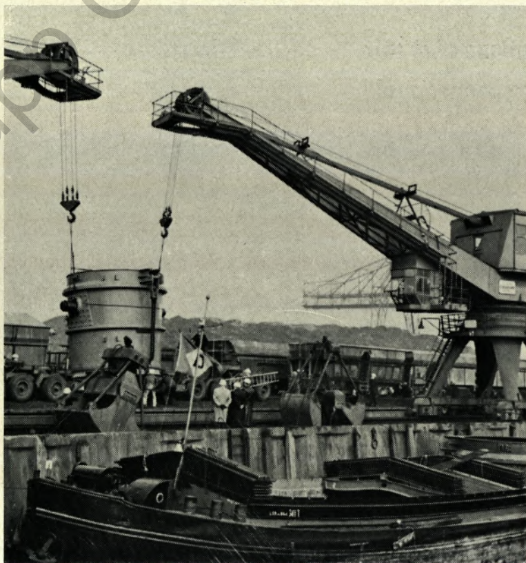
Die Pfanne wird auf einen Spezialtiefladewagen abgesetzt.
