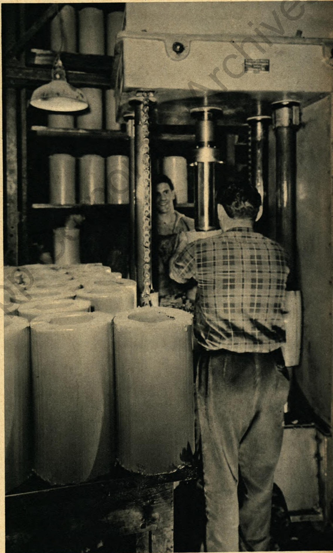
► Unser Bild zeigt eine Rohrpresse, an der die Italiener Cataldo und Santo Gießrohr-Steine für Stahlwerke pressen
