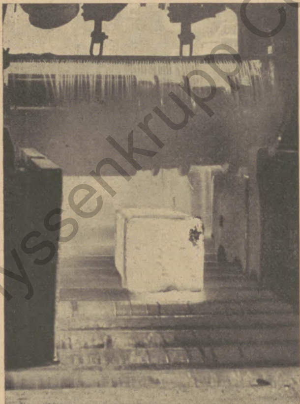
Ein Rohblock zwischen den beweglichen Linealen bei der Einfahrt in die Blockstraße I in Ruhrort. Links die Brammenbahn, rechts die Kaliber. Die Walzen werden durch Wasserberieselung gekühlt.
