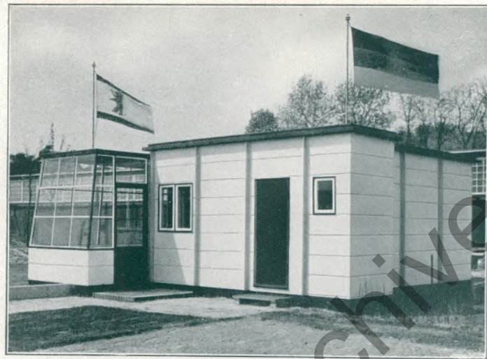
Abb. 5. „Haus in Stein und Eisen.“ Architekt: Max Laut.
