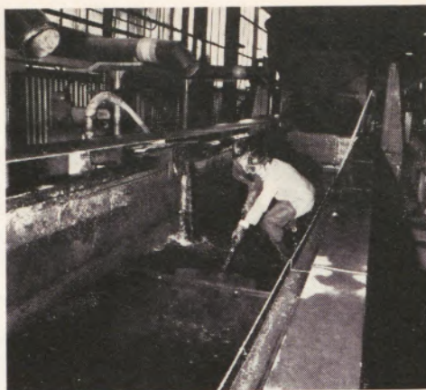
Bild 1: Reinigungsarbeiten im Beizbottich
