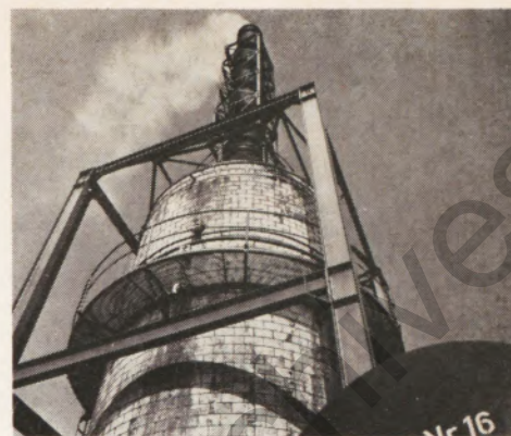
Bild 6: Die gereinigten Säuredämpfe gelangen über hohe Kamine ins Freie
