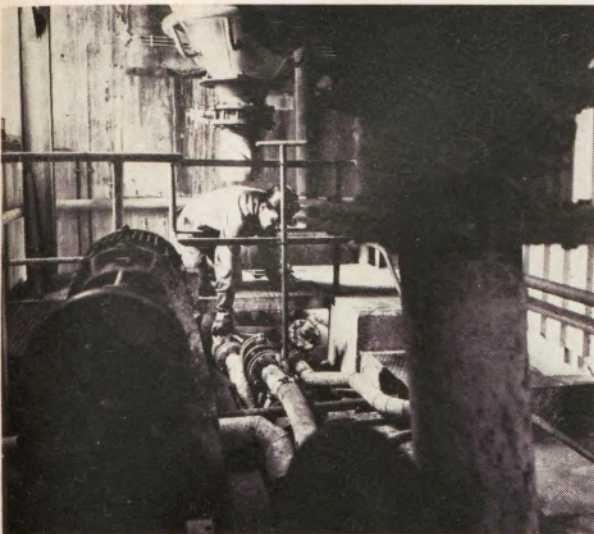
Bild 4: Arbeit unter den Kalksilos
