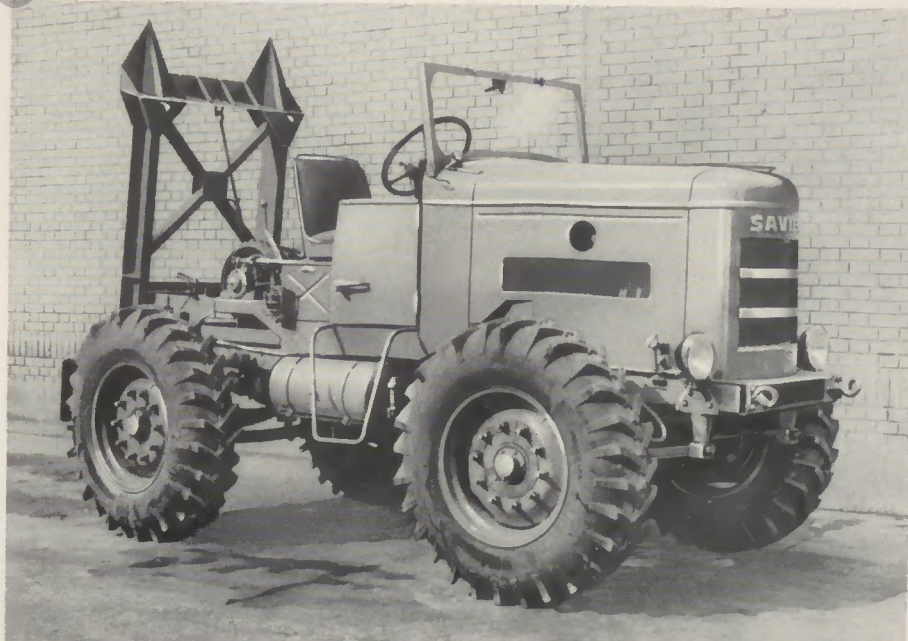
Abb. 20 Saviem-Renault-Forstslepper TL 23 80 PS nach DIN, 85 BHP nach SAE gross
