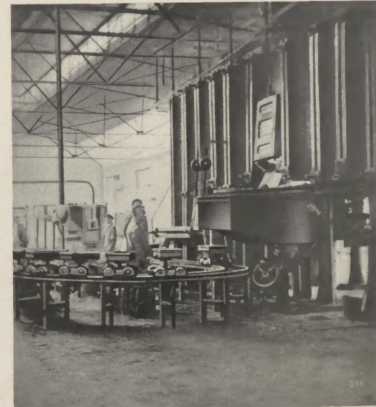
Schmelzofen mit Sandformen
