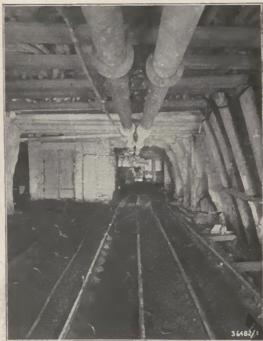
Abb. 8: Abbaustreben mit Rappschienen auf Holzpfilern
