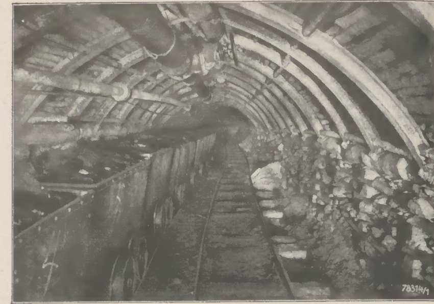
Abb. 9: Abbaustrebe mit Stahlbögen auf Holzpfilern
