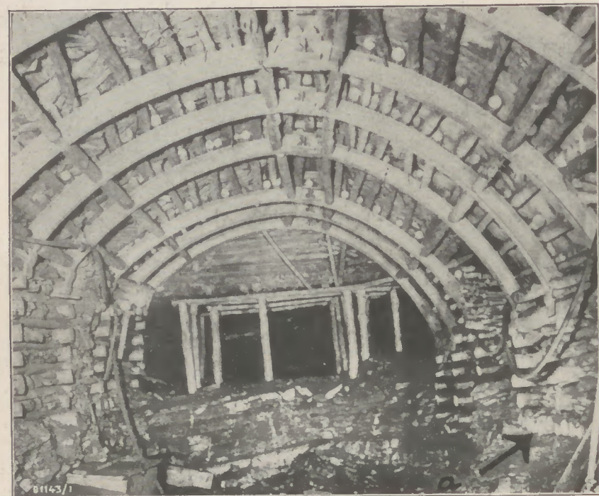
Abb. 7: Abbaustrebe mit Stahlbögen auf Holzpfilern — a = Stempel neben Stempel auf dem gebräunten Liegenden
