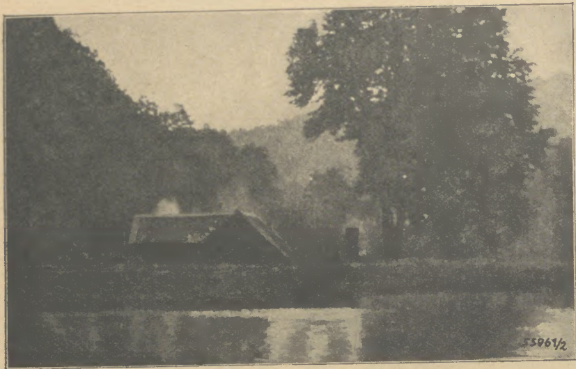
Wasserhammer im Marschheidertal
