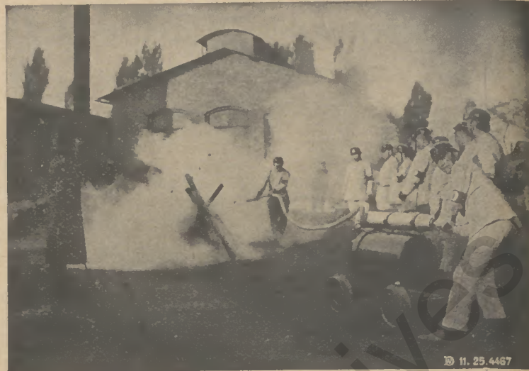
Feuerlöschprobe mit Grubenfeuerlöscher Total-Tübben des Draeger-Werkes, Lübeck, auf Zeche „Königin Luise“.
