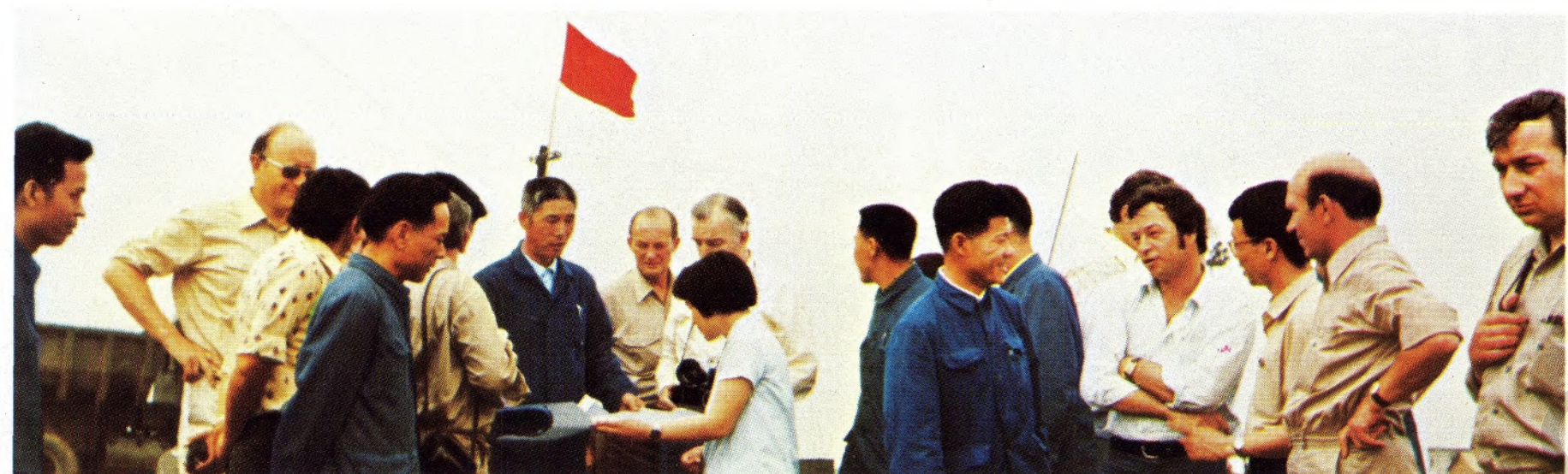
Bild oben: Deutsch-chinesische Fachgespräche mit Hilfe der Dolmetscher auf der Baustelle des künftigen Kaltwalzwerkes in Wuhan. Für die ausgebreitete technische Zeichnung benötigen die Techniker keinen Dolmetscher.
