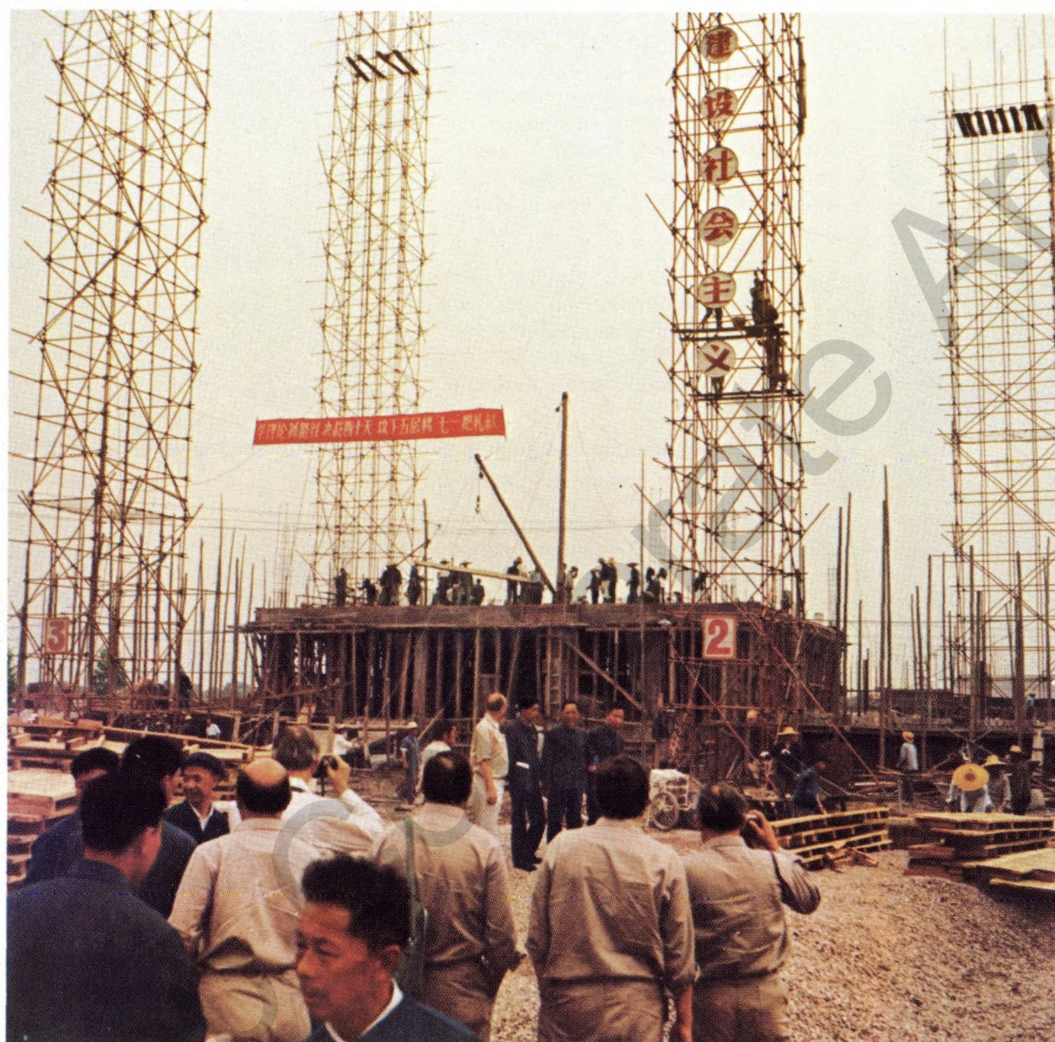
Bild links: Hier entsteht das Hotel, in dem die ATH-Mitarbeiter während ihres China-Aufenthaltes wohnen werden. Die hohen Baugerüste sind aus Bambusstangen gebaut worden. Den deutschen Besuchern fiel zudem der hohe Personaleinsatz auf und die Lautsprechermusik, zu der die chinesischen Bauleute arbeiteten.
