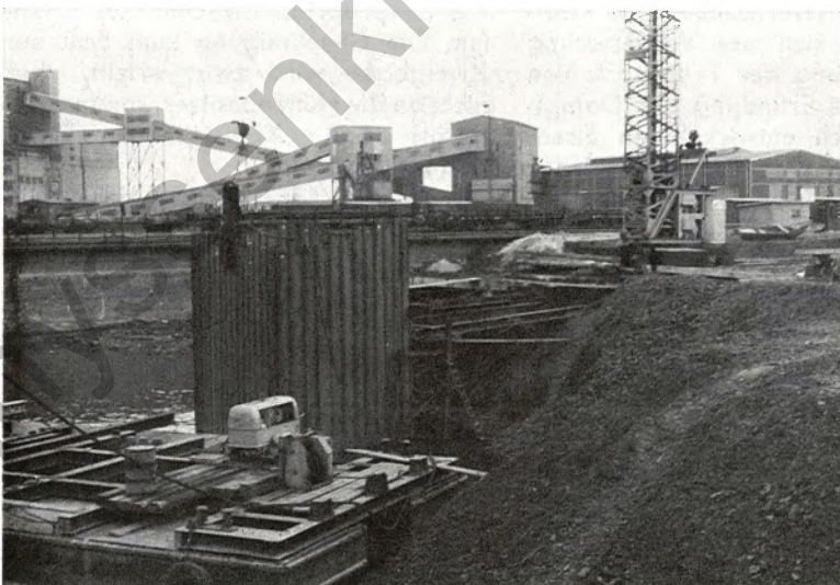
1. Kreisringzelle zur Aufnahme einer wasserseitigen Stütze.
