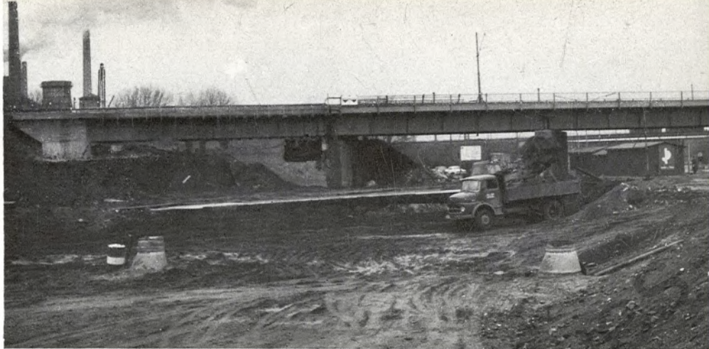
Ansicht des südlichen Überbaues. Der Erdkern des Bahndammes unter dem Überbau steht noch.
