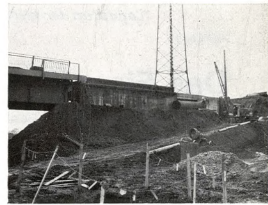
Niederbringen der Bohrpfeiler für das Widerlager des nördlichen Überbaues.
