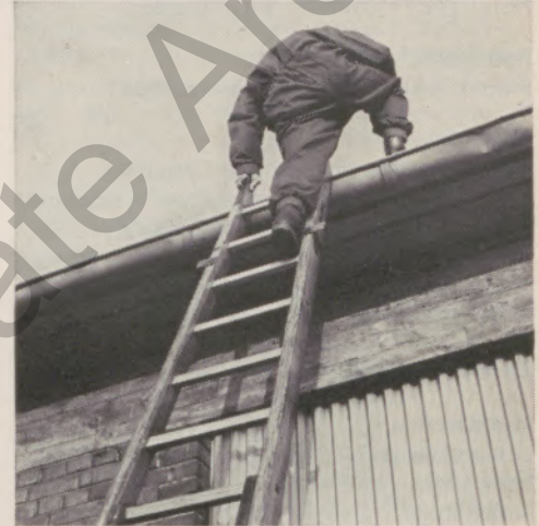
Ein häufig zu beobachtendes Fehlverhalten. (Dieses Bild wurde jedoch gestellt.) Damit Leitern an ihrem oberen Ende gefahrlos verlassen und betreten werden können, müssen ihre Holme 1 m über die zu besteigende Stelle hinausragen.
