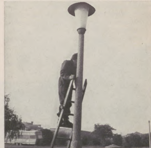
Wir wollten die Belegschaftsangehörigen, die wir bei dieser oder ähnlicher gefährlicher Handhabung der Leitern sahen, nicht bloßstellen und haben auch diese Aufnahme gestellt. Jeder sollte jedoch wissen, daß Anlegeleitern nur an sichere Stützpunkte angelegt werden dürfen, und zwar so, daß beide Holme aufliegen.
