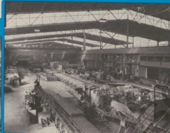
Fertigstrecke des Stabstahls
