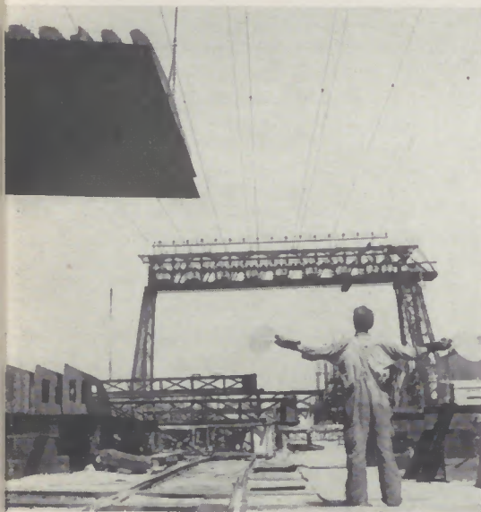
Auf der Helling: Einwinken eines Spantenteils
