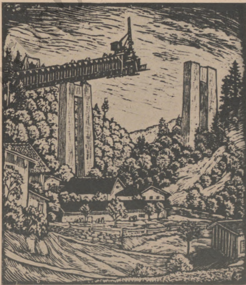
Reichsautobahn: Bau der Mangfallbrücke bei Holzkirchen (Vortreiben der Brücke im Frei-Borban) / Holzschnitt: Georg Tyroler
