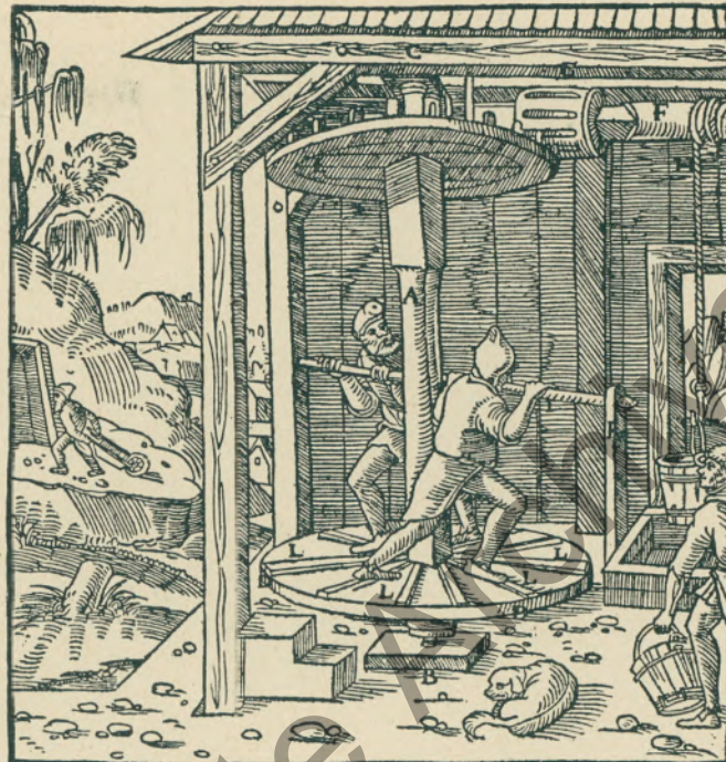
Abb. 1. Schachtförderung durch eine Haspelwelle. Abb. 2. Schachtförderung durch die „runde Scheibe“. (Aus Georg Agricola: „Zwölf Bücher vom Berg- und Hüttenwesen“, Lateinische Ausgabe 1556.)
