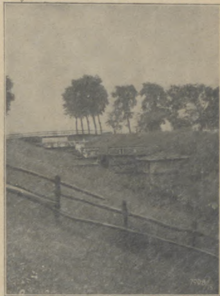
Schleuse bei Haus Horst
