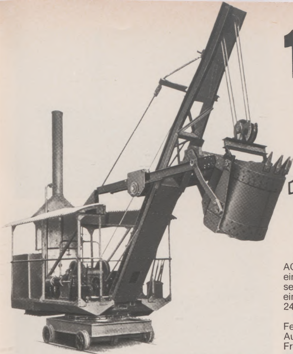
▲ Einer der ältesten O&K-Bagger ist dieser Löffelbagger aus dem Jahre 1908 mit Heißdampf-Antrieb . . .
