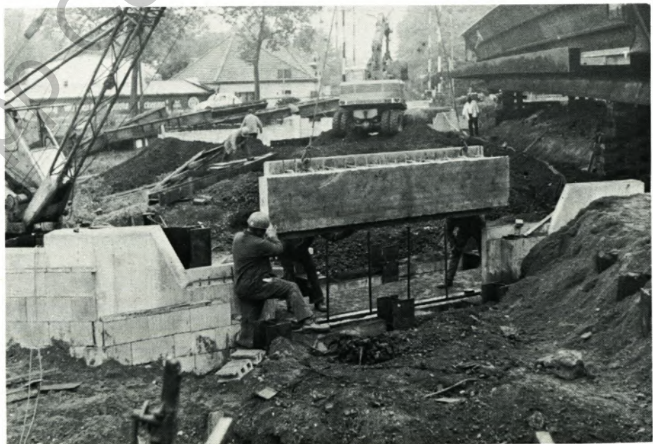
Schließen der Kammermauer durch ein Betonfertigteil
