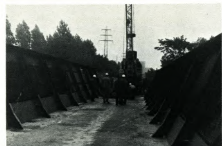
Der EH-Kran beim Verlegen der Gleisjoche
