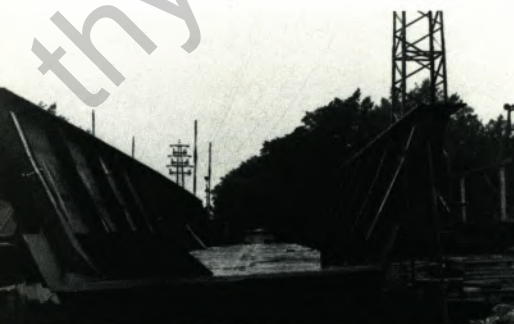
Der zusammengebaute Überbau vor dem Einfahren
