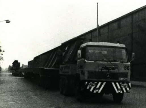
Antransport der beiden neuen Brückenhälften
