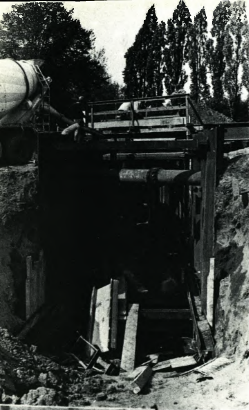
Im Schutze einer Hilfsbrücke wird ein Widerlager erstellt
