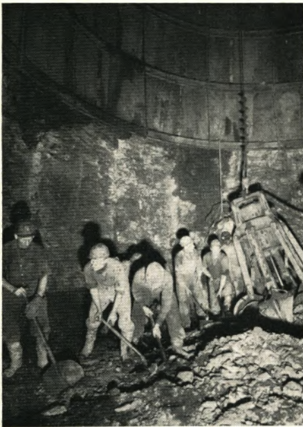
Titelbild: In 890 Meter Teufe, auf der Sohle des Hansenschachts der Altenessener Bergwerks-AG, wurde dieses Bild während der letzten Abteufschicht aufgenommen. Zum letztenmal lockern die Schachthauer das Gestein, bevor es der Greifer in den Kübel schüttet.
