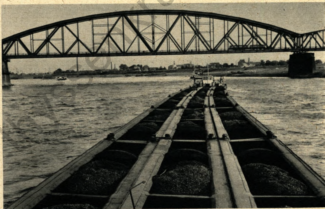
▲ Mitten auf dem Strom stoppte der Zug. Schnell und sicher rangierte das Bugschiff mit den Rohren. 66 Kilometer hat das Lastrohrfloß während dieser Versuchsfahrt auf dem Rhein zurückgelegt
