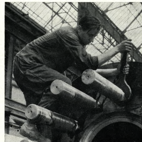
Hochdruck-Wickelbehälter für die chemische Industrie werden in Mülheim hergestellt. Hier ein solcher Behälter in der Fertigung
