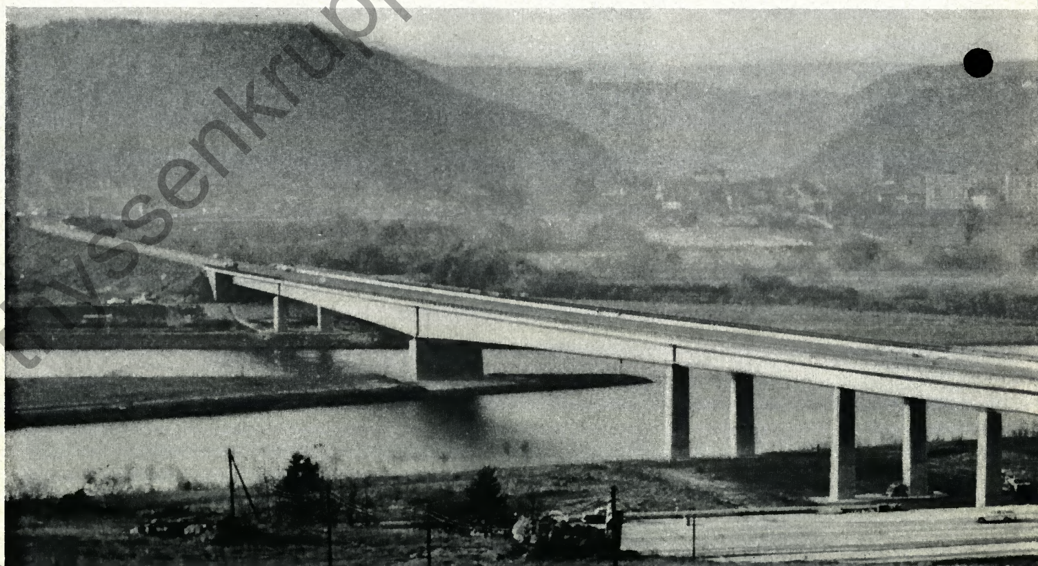
Die neue Moselbrücke bei Ehrang, die das Trierer Hafengebiet an das örtliche Verkehrsnetz anschließt und die Verkehrsverbindung zwischen Rhein
