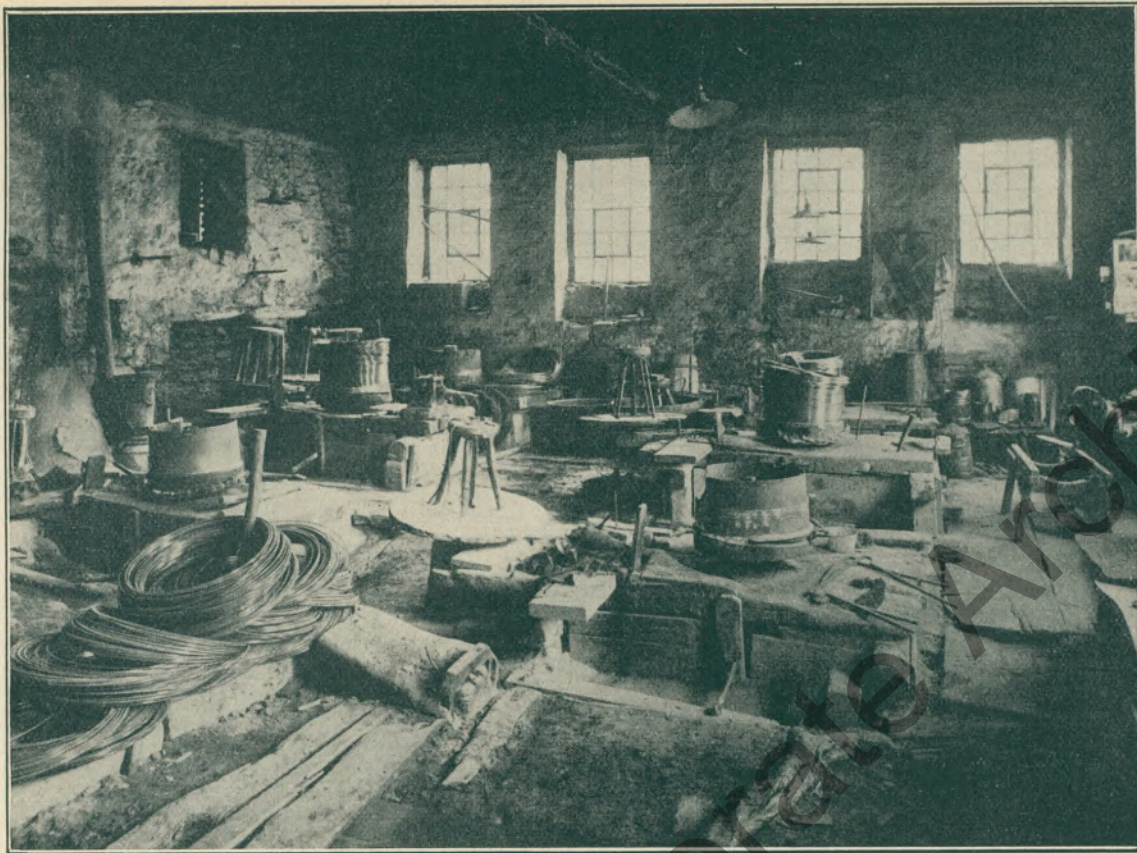
Inneres einer Altenaer Drahtrolle (Krautmühle),
