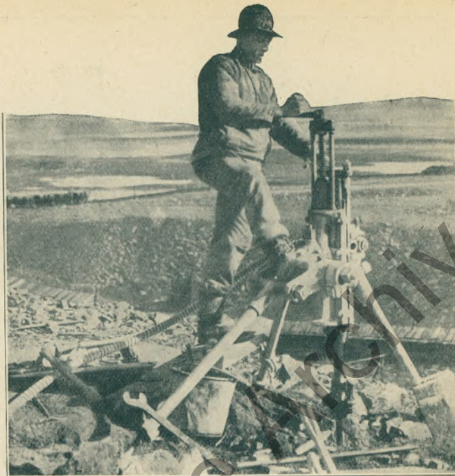
Sprenglochbohrung.
