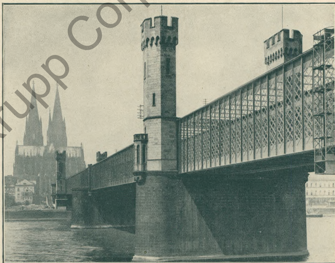
Blick auf die alte Kölner Rheinbrücke, für die die Firma „Gebrüder Knipping“ die Nieten lieferte.
