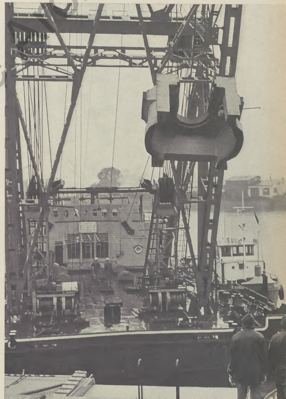
Keiner der Kräne im Düsseldorfer Hafen war in der Lage, den Ständer unserer neuen Lochpresse zu verladen. Darum mußte aus Koblenz der 200-t-Schwimmkran „Cyclop“ herbeordert werden. Das Bild zeigt den Abstreifer zur Lochpresse bei dem Entladen aus dem Schiff.
