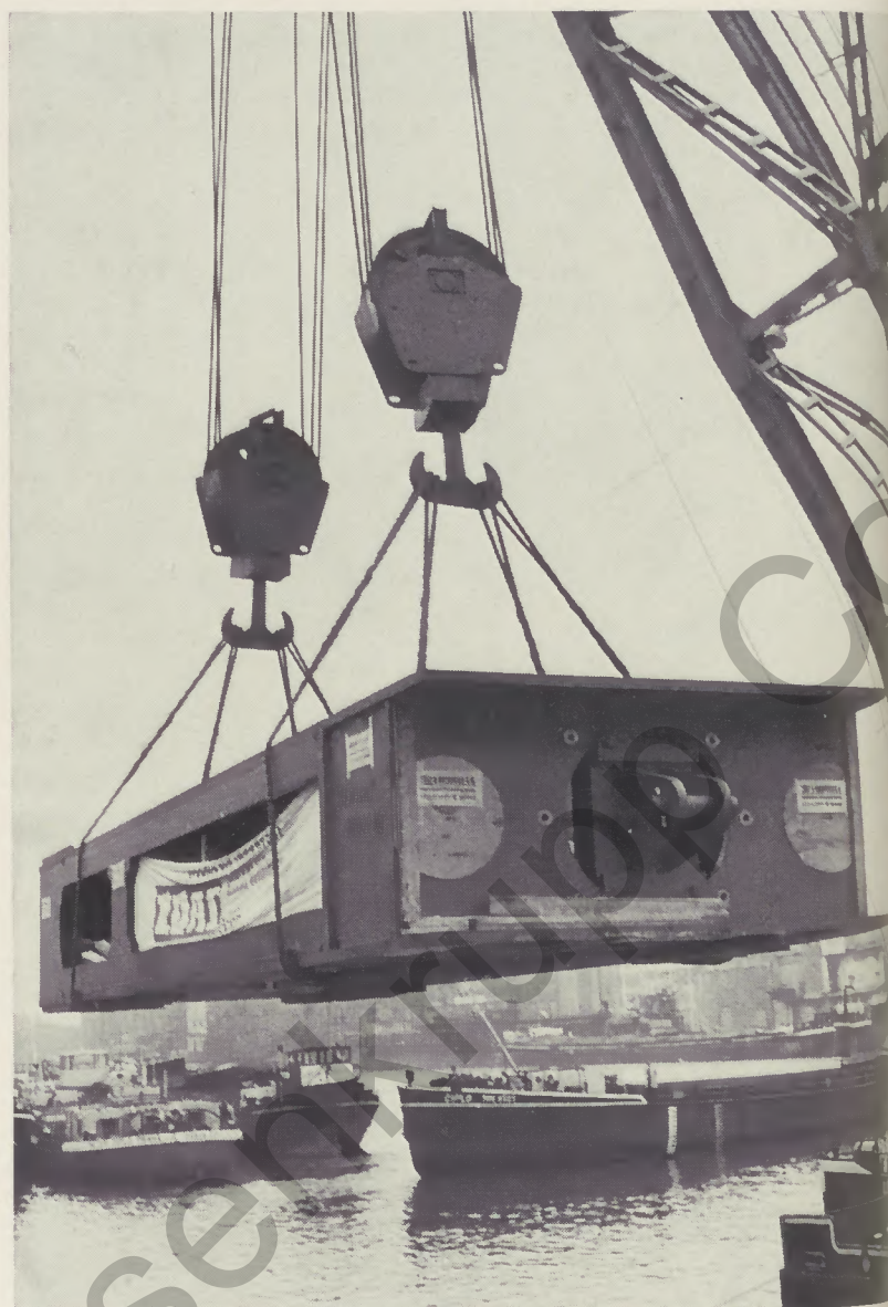
Der Ständer unserer neuen Lochpresse war das schwerste Stück, welches jemals im Düsseldorfer Hafen umgeschlagen wurde. Ein Taucher mußte Kaimauer untersuchen, ob sie dieses Gewicht ohne Risiko tragen konnten.
