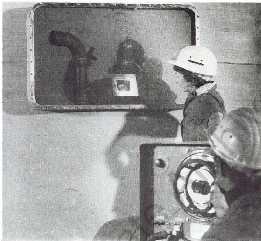
Probeschweißen im Werk vor dem Einsatz in Hannover: Der durch das Fenster sichtbare Taucher (Schweißer) steht im Wasser des Tauchbeckens – eine der Thyssen-Attraktionen der Hannover-Messe.
