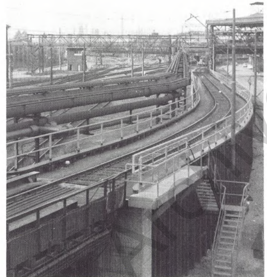
Ein neuer Bahnkörper nach Beendigung der Umbauarbeiten. Man sieht ihm nicht an, welche Arbeit darin steckt.
