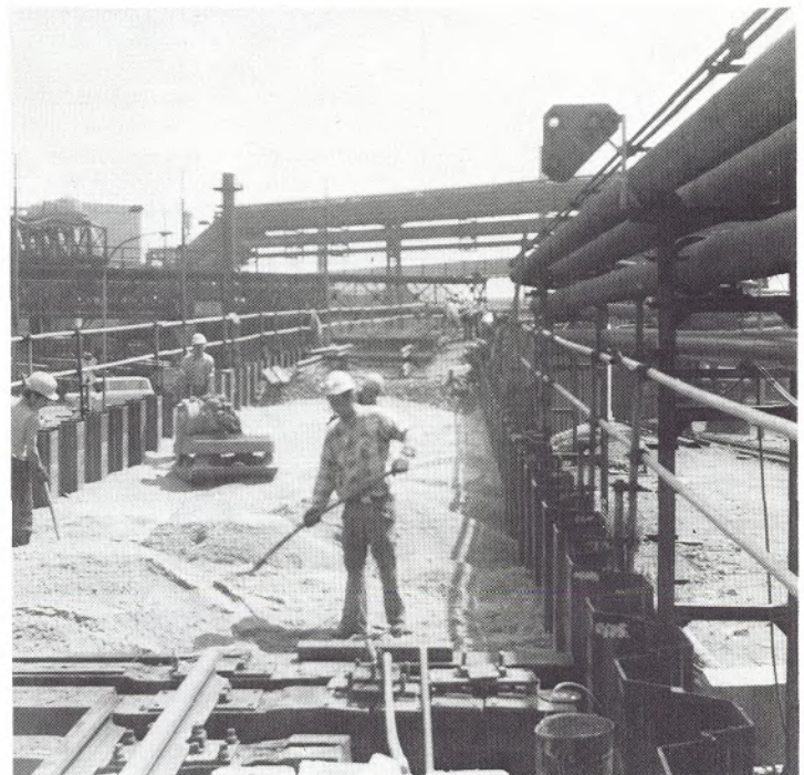
Eine Gleisbrücke wird in den riesigen Sandkasten gehoben und montiert (links). Ladung auf Ladung Kies wurde zwischen die Spundwände gekippt und verdichtet.
