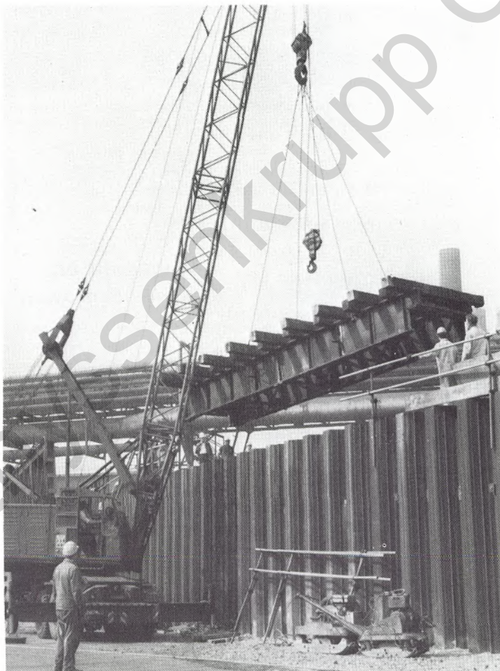
Eine Gleisbrücke wird in den riesigen Sandkasten gehoben und montiert (links). Ladung auf Ladung Kies wurde zwischen die Spundwände gekippt und verdichtet.
