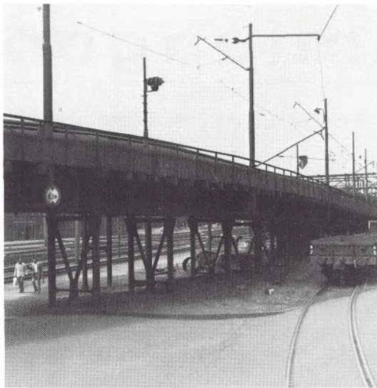
Die alte Pfeilerbahn vor Beginn der Bauarbeiten. Immer mußte sie provisorisch betriebsbereit gehalten werden. Der Vergleich zum Bild rechts zeigt den Unterschied.
