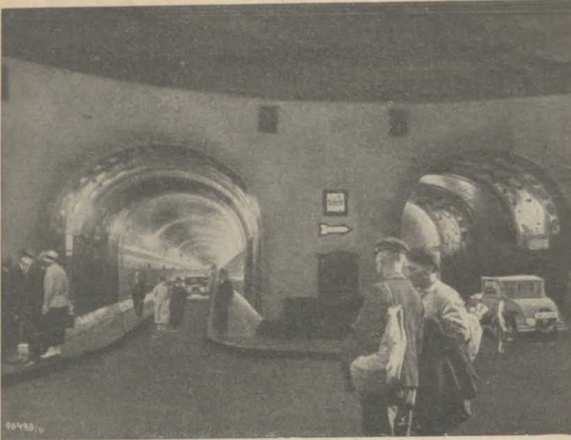
Außen- und Innenansicht des Elbtunnels
