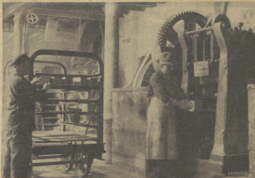
Bild 4: Presse zum maschinellen Verdichten der Steine
