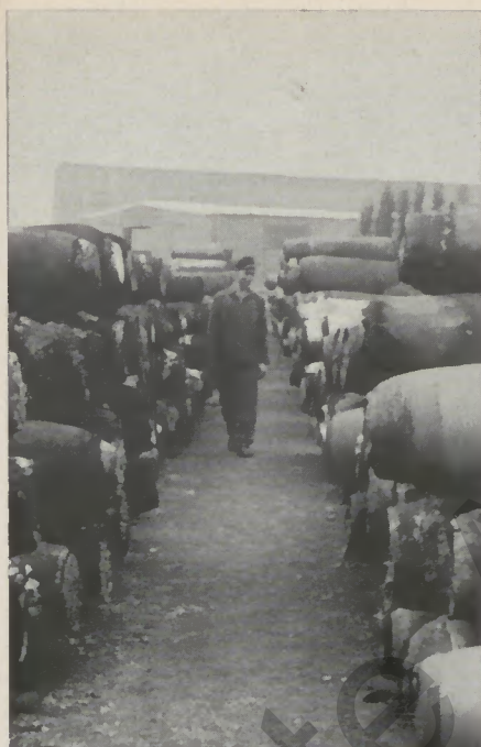
Zwei gut begehbare Blockplätze, wie hier unser Mitarbeiter Franz Ipsch feststellt, helfen den gefährlichen alten Blockplatz entlasten.
