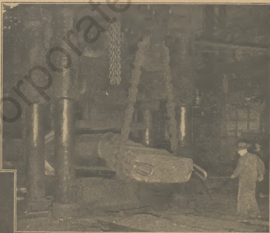
Fertigwalzen des Reifens
