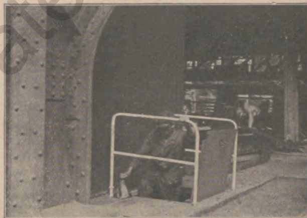
Bild 4: Der Mann steckt das Geländer in die dafür vorgesehenen Öffnungen im Bodenbelag
