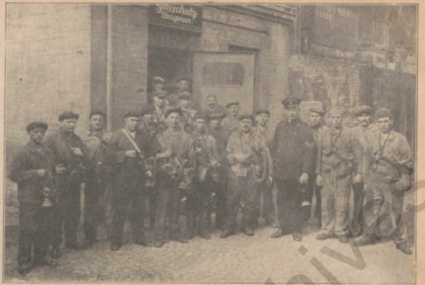
Bild 7: Ofenmannschaft des Walzwerkes nach einer Übung im verqualmten Gashöhungsraum
