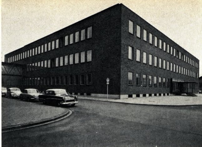
Unser neues Forschungsinstitut im Werk Thyssen, in das schon die ersten Mitarbeiter einzogen. Die Einweihung erfolgt im Herbst dieses Jahres.
