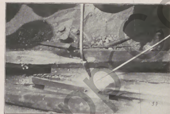
Abb. 84: Schweißen eines Herzstückes
