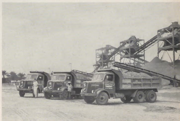
Abb. 12 Der technisch-wirtschaftliche Fortschritt im Kongo wird hier deutlich sichtbar. Henschel-Lastwagen beim Transport von Schüttgut für den Straßenbau
