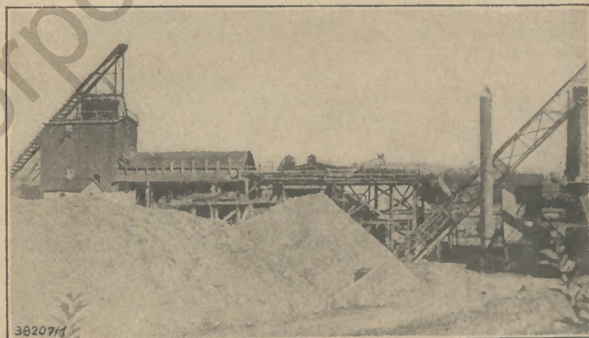
Das Waschen und Trocknen der Phosphate. Das Rohmaterial der Phosphatlager wird durch den Elevator links in den Waschapparat befördert und dann mittels des Elevators rechts zur Trockenanlage geführt
