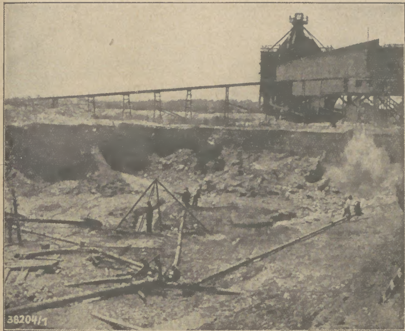
Das Herausspülen der Phosphatknollen aus Sand und Lehm durch starke Wasserströme
